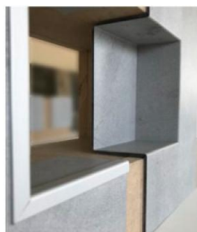
Nischenverkleidung 1 Platte seitlich gekantet, 1 Platte 4-fach gekantet
